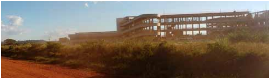
Construção do Campus UFU em Monte Carmelo
